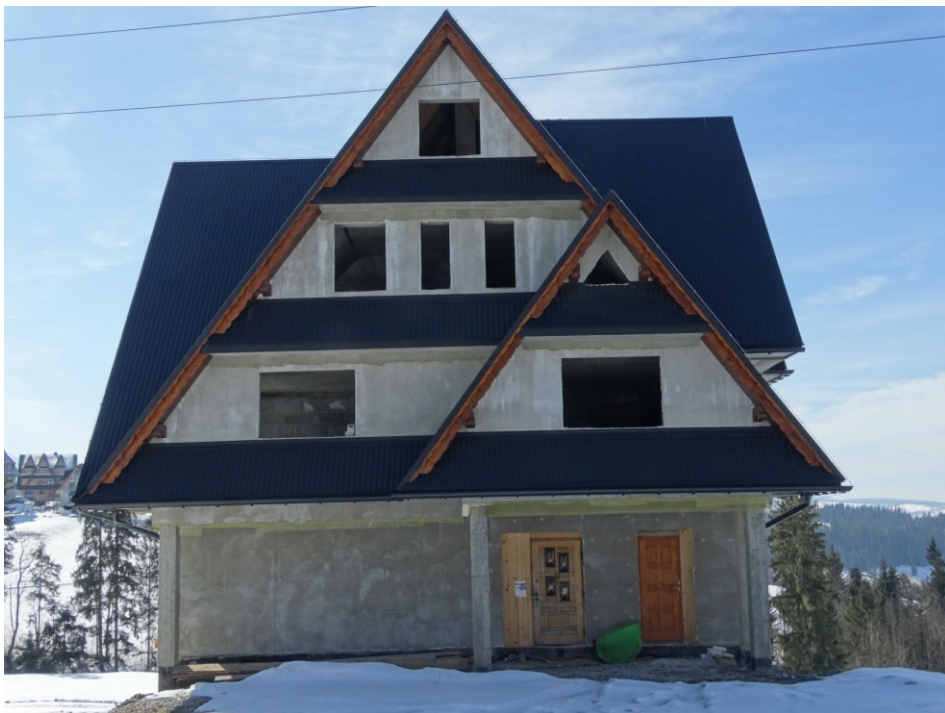
Budynek od strony północnej 4 kondygnacje
