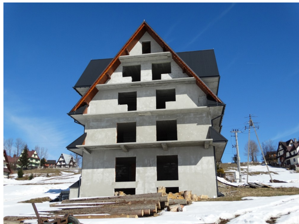
Budynek od strony południowej 6 kondygnacji
